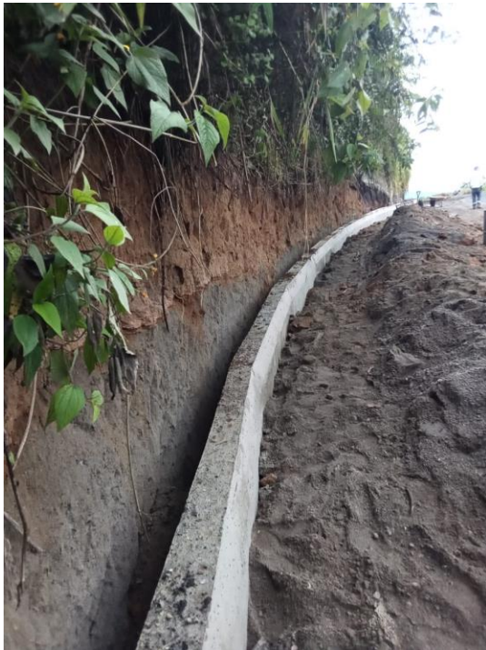
CONFORMACION DE LA VIA YUNGUILLA PARA ADOQUINARLO
